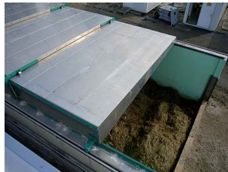
Hydraulicky vysouvatelné zakrytí betonových nádrží Konstrukční řada ZBC
