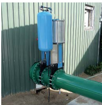
Přímý přívod z dávkovače biomasy do fermentoru
